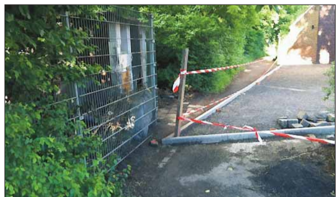
Vor den Sanierungsmaßnahmen.
