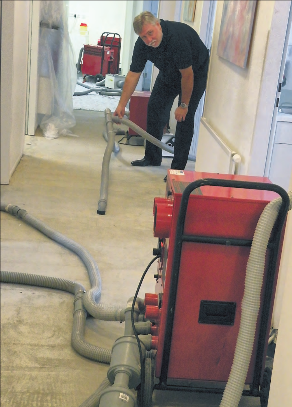
Trocknungsgeräte beherrschen zurzeit das Bild in der Praxis, hier dem Chirurgen Frank Cammann, der voller Ungeduld den Fortgang der Renovierungsarbeiten verfolgt.
