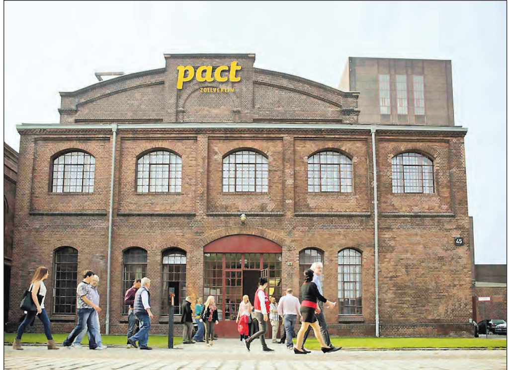
Außenansicht der ehemaligen Waschkau von Zollverein 1/2/8.
