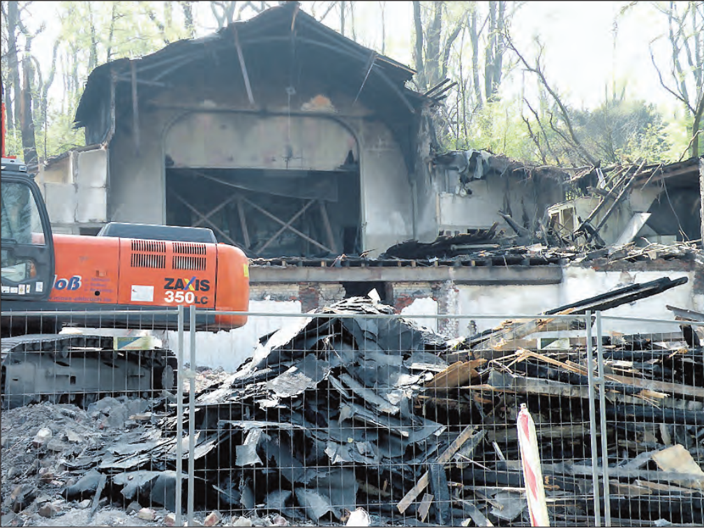
Der Abriss der Brandruine geht voran – Stand 24.4. 2015.
