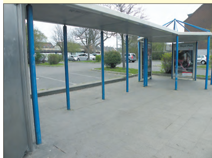
Zustand der Bushaltestelle am Karl-Meyer-Platz (Saatbruchstraße) am 10. April 2015. Foto: Willi Zimmermann
