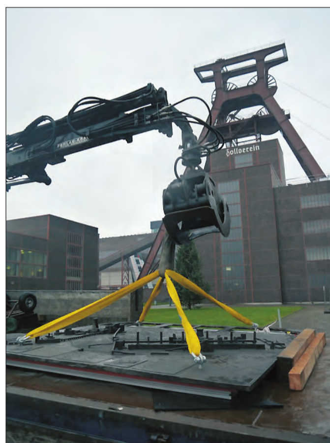
Die 400 Kilogramm schweren und zweimal zwei Meter großen Modelle mussten mit einem Kran aufgestellt werden. Fotos: Hannah Bontke/Stiftung Zollverein
